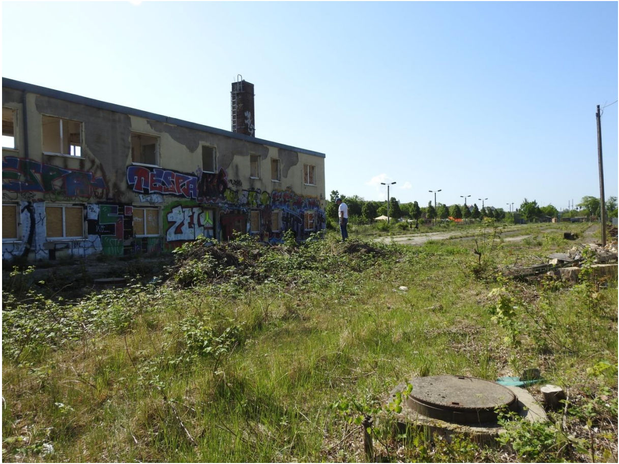
Abb. 9: Brombeerbereiche mit Betonrändern und lockerem Substrat auf Baufester bzw. Baunebenflächen des B-Planes, 2022 mit Zauneidechsen nachweisen
