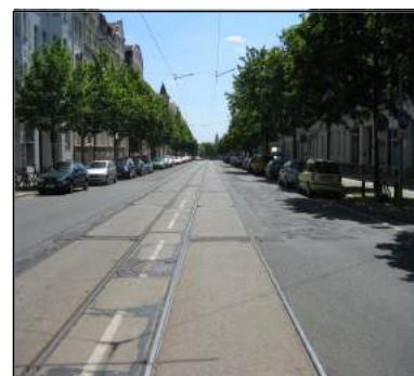
Unsanierter Abschnitt Landsberger Straße
