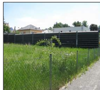
Vorhanden Lärmschutzwand am Knoten Essner-/ Delitzscher Straße
