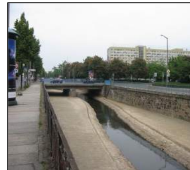
Ist-Zustand der Partheufer
