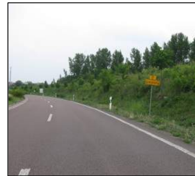
Lärmschutzwall an der S1
