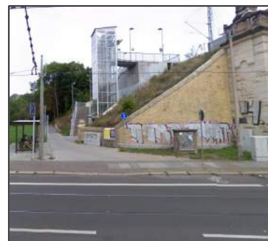
Bestehender Radweg Bhf. Gohlis
