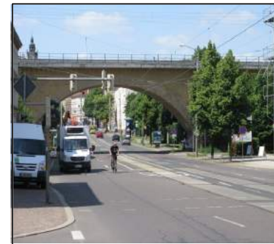
Georg-Schumann-Str. in Richtung Viadukt
