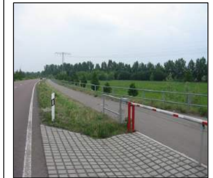
Abschnitt ohne Lärmschutz
