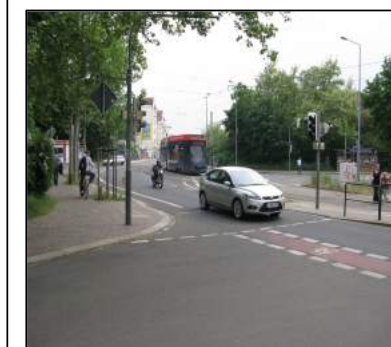
Sanierter Abschnitt am Coppiplatz
